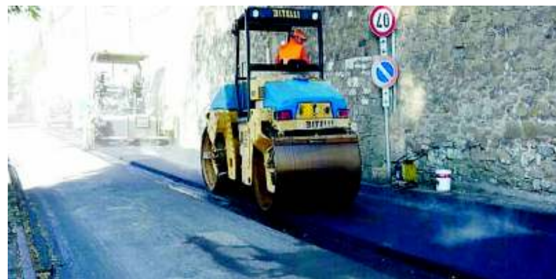
Lavori in via Enrico Dal Pozzo
